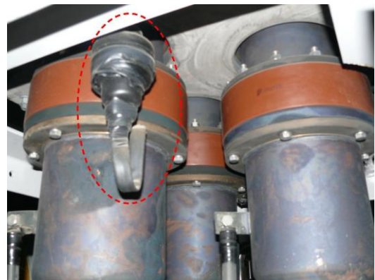
圖 2b 安裝於 GIS 遮蔽層(金具)之 SVL
