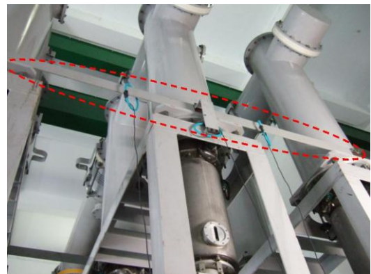
圖 2a GIS 外殼三相短接銅排
