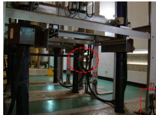
圖 2 獨立分開接地線
