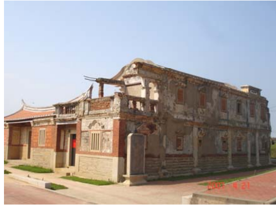
圖3 除彈孔被填平之外的「北山洋樓」，側邊已被翻新。(郭朝暉提供，2007)
