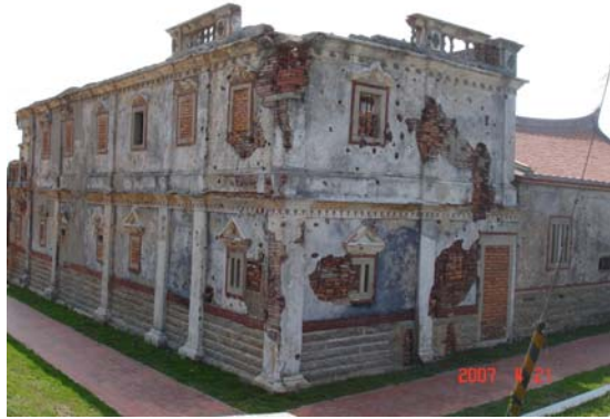
圖2 因砲戰期間而留下大量彈孔的「北山洋樓」，目前部份被填補。(郭朝暉提供，2007)
