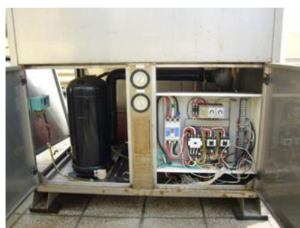
(b) 壓縮機及控制電路
