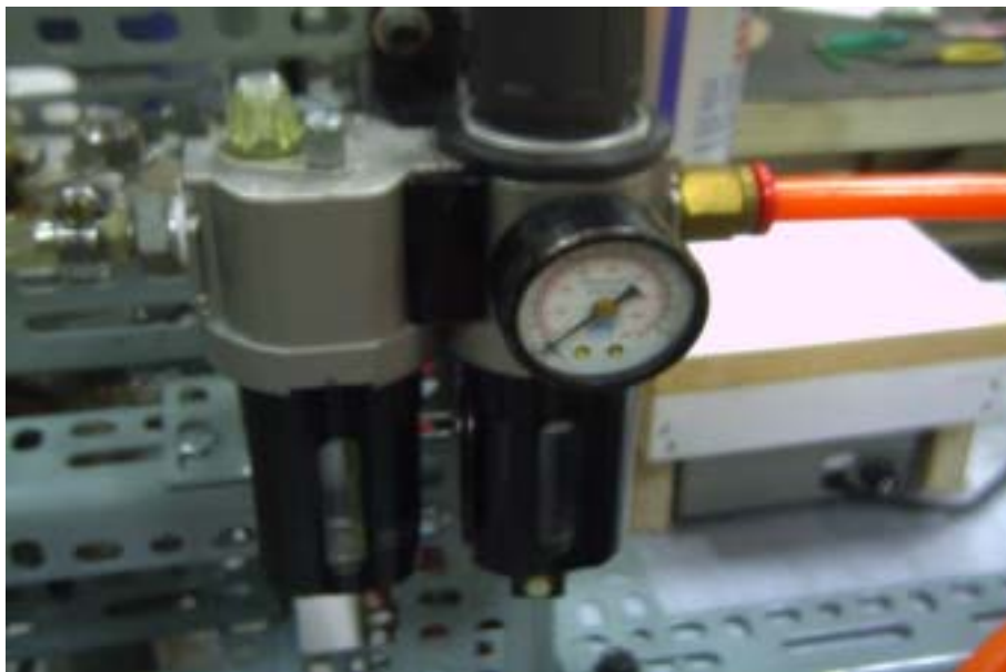
圖 6-13 調壓過濾器裝設
