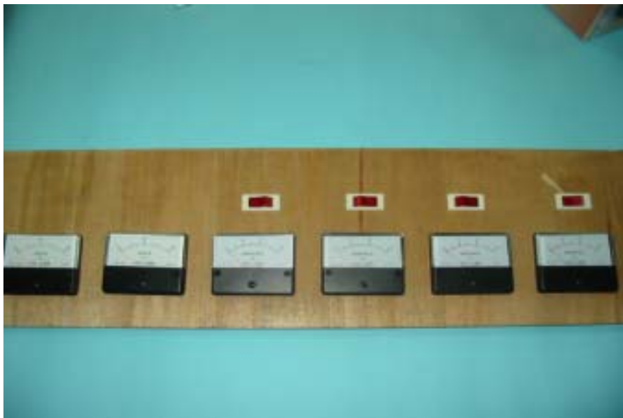
圖 6-7 電壓、電流錶安裝加工
